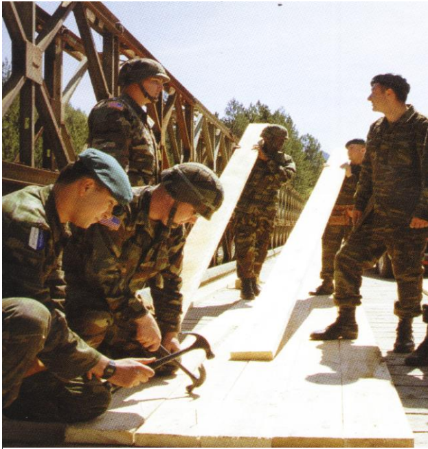
Bauen von Brücken
